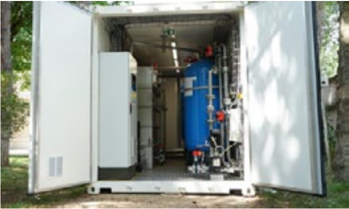
Contener UnYo® : solution mobile pour traiter l’eau douce et fournir de l’eau potable
